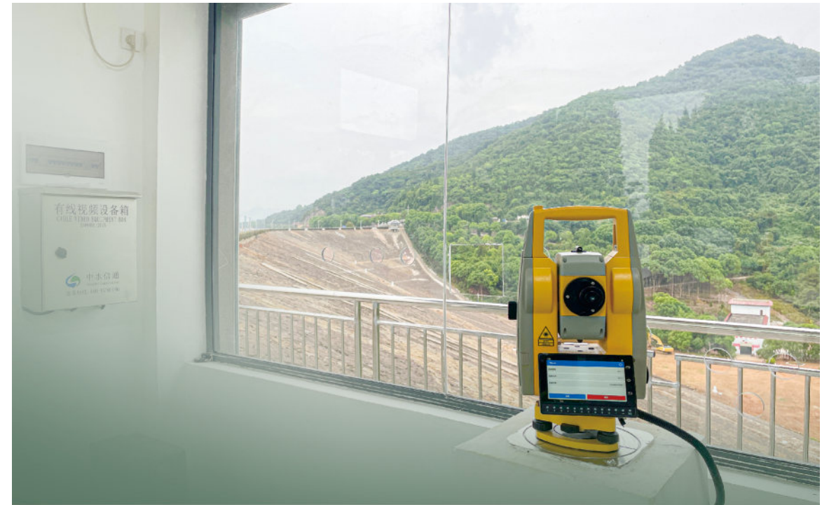
温峡水库自动化监测项目
