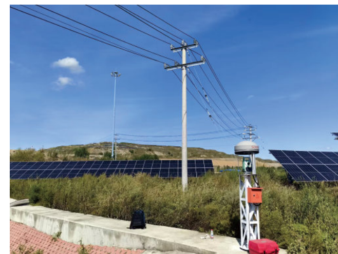
南方机器人正广泛应用于水利、隧道、能源等多个场景
