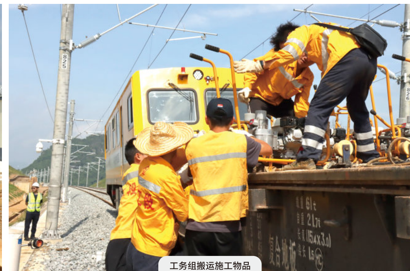
工务组搬运施工物品
