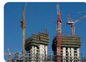
施工竣工测量
