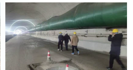
隧道、涵洞等封闭地形" data-bbox="836 760 926 777"/>
