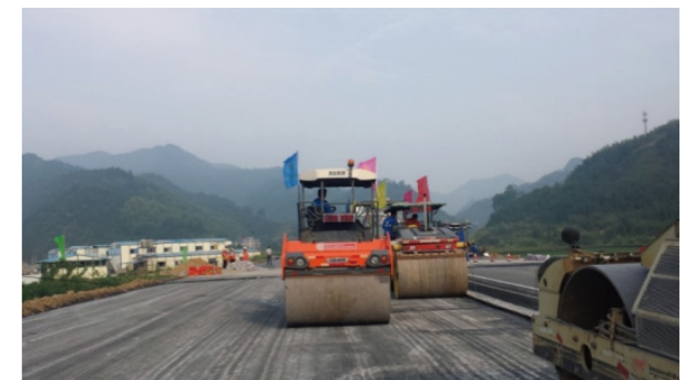
筑路施工智能压实系统
